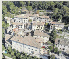
A fianco il borgo di Cesi. Nuovi cantieri in arrivo
